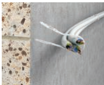
Приложение на стягаща скоба "BKS" Направете отвори, захванете със скобата "BKS" кабела и я въведете в отвора.
