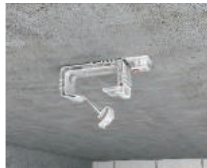
Монтаж към таван Събирателната скоба "Grip" е закрепена към тавана.
