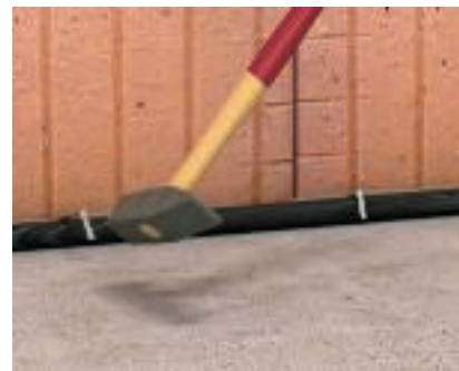
Приложение на пирони с куки Пиронът с кука се забива в монтажната основа. Внимава да не се деформира тръбата. Поради тази причина закрепването на кабели/проводници с пирон с кука е рисковано и трябва да се внимава.
