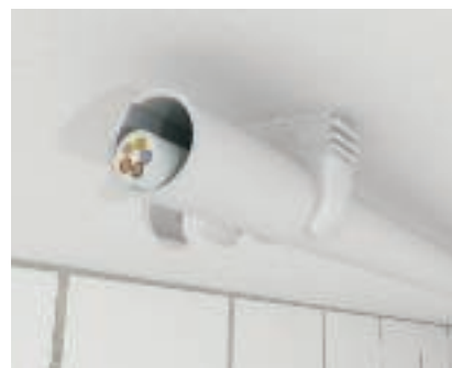
Готов монтаж на "Quick-Pipe" Затворената тръба фиксира проводника. Системата "Quick-Pipe" е идеална за полагане на предварително оразмерени проводници.
