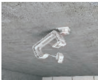
Закрепване на събирателната скоба Посредством издърпване и завъртане крепежният елемент се отделя от събирателната скоба "Grip".
