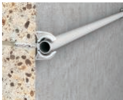
Монтаж на скоба "Snap" Предварително фиксирайте скобата с помощта на дюбела в отвора. Поставете след това тръбата и притиснете скобата с тръбата в монтажната повърхност.
