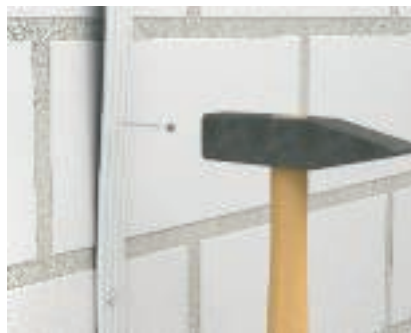
Приложение пирони "Siko" Пиронът "Siko" се поставя в средата между жилата на мостов проводник.
