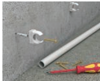
Приложение дюбел с винт "Sprint" Дюбелът "Angler" се поставя в отвора и скобата се закрепва с винт "Sprint".
