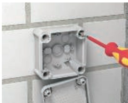
Закрепване към стената през ъгловите проходни отвори От размер над Т 60, разклонителните кутии могат да бъдат монтирани към основата през отворите в подсилените ъгли за закрепване на капака.
