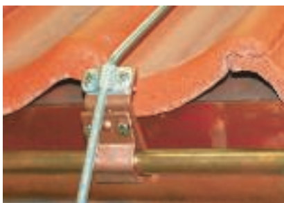
Коректна инсталация с помощта на биметален съединител (алуминий/мед)
