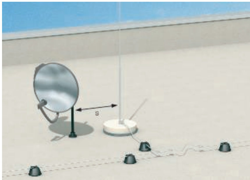
Коректно спазена разделителна дистанция ( s ) между мълниеприемното оборудване и сателитното съоръжение
