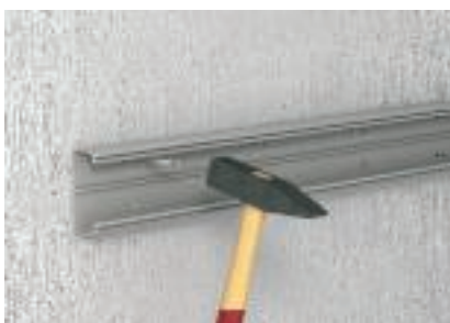
Монтаж на канали
