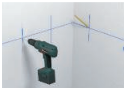
Монтаж към стената
