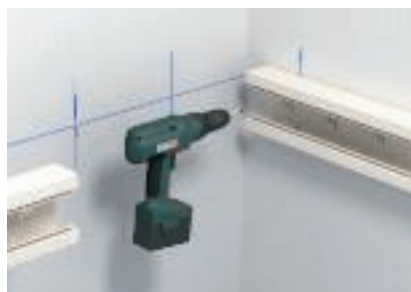
Монтаж към стената
