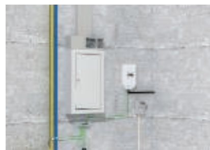
WDK в помещение за инсталиране на консуматор
