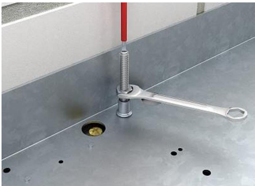
Kanaleinheiten auf Oberkante Estrich feinjustieren. Bodenplatten der Nivelliereinrichtung auf Rohdecke befestigen. Höheneinstellung der Nivelliereinheiten prüfen und durch Kontermutter sichern.
