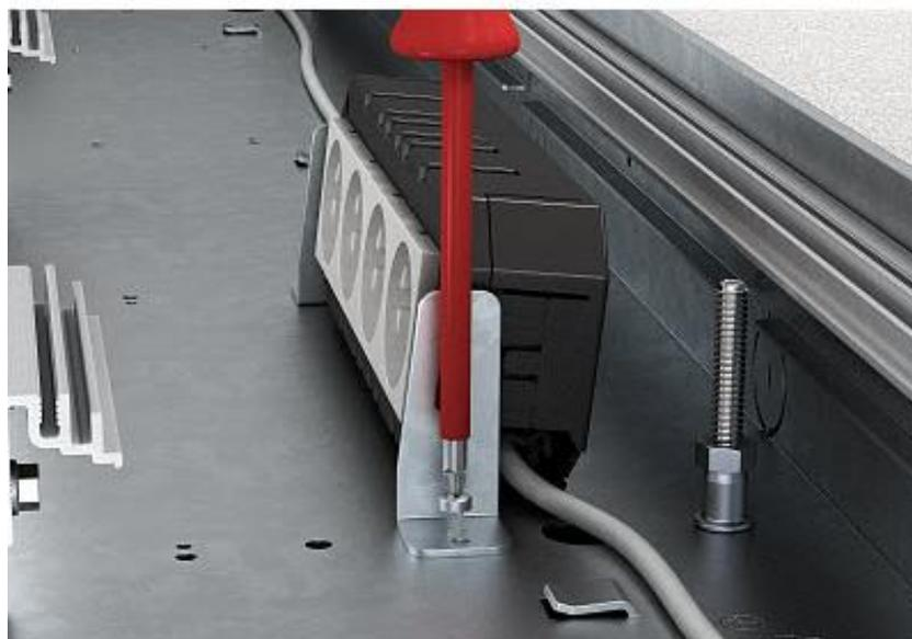
Nach dem Anschluss der Installationsgeräte im Modulträger oder Gerätebecher, werden diese mit Hilfe des Geräteträger **OKB IT** an den entsprechenden Stellen in der Bodenwanne des Kanals montieren.
