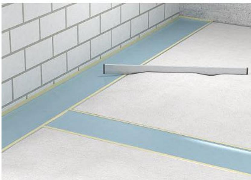
Der Estrich sollte unmittelbar nach der Montage des OKB-Kanalsystems eingebracht werden. Falls erforderlich, sind Kanalstöße abzudichten. Der Estrichleger ist gehalten, die Seiten des Kanals sorgfältig und sauber mit Estrich anzuarbeiten. Eine Trennlage von 3-5 mm ist zulässig, muss jedoch unterhalb des Auflageprofils enden.
