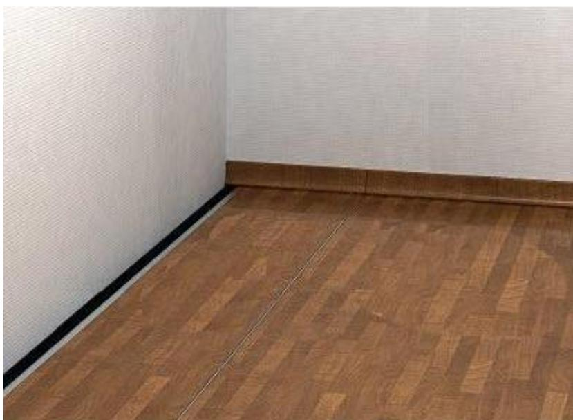
Anschließend die Fläche zum Raum hin mit dem entsprechenden Bodenmaterial belegen. Die Deckel werden mit den Rastklammern im Aluminiumprofil fixiert und liegen an den Stoßstellen auf den Stoßstellendichtungen auf (3 Stück auf 2 m).
